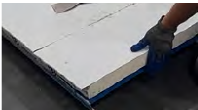
1 Pasar una espátula por el borde entre la chapa y el núcleo.
