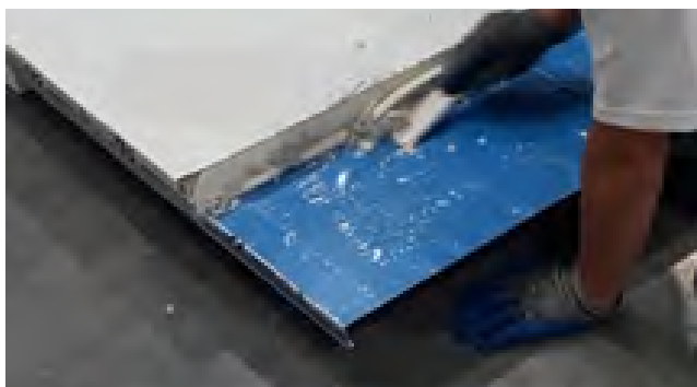
3 Retirar los restos de núcleo.
