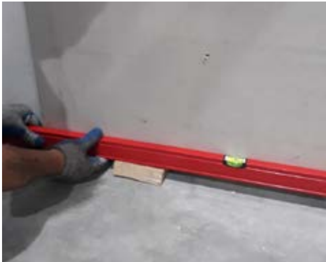
Colocar cuñas de madera para ajustar el plomo y nivel. Usar un nivel de mano de 1m
