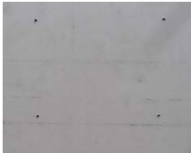
Realizar perforaciones atravesando el panel cada 40 cm en ambas direcciones.
