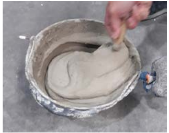
Preparar el adhesivo tipo basecoat monocomponente de acuerdo con las indicaciones del fabricante.
