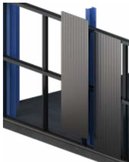
Verificar siempre la alineación y plomo
