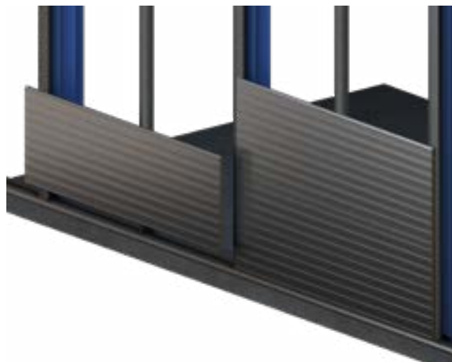
Colocación del primer panel del siguiente tramo.
