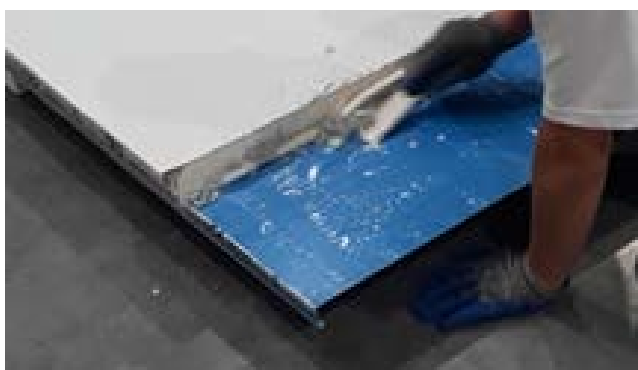
Retirar los restos de núcleo
