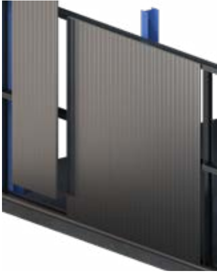
Colocación del último panel próximo a la esquina. Chequear necesidad de ajustes.
