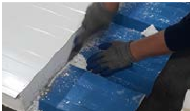
Retirar los restos del núcleo que quedaron en la cresta con ayuda de una espátula
