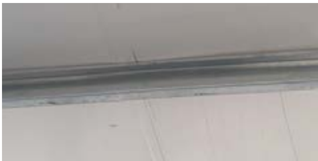
Superposición del foil dando continuidad a la barrera de vapor.
