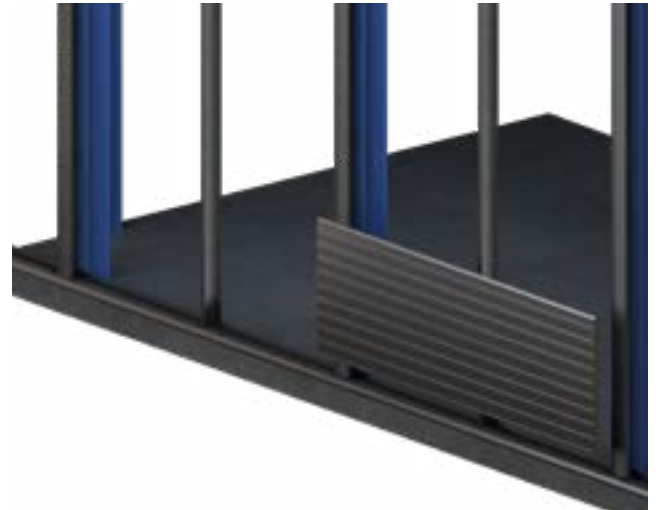
Colocación del primer panel de acuerdo con el replanteo inicial.
